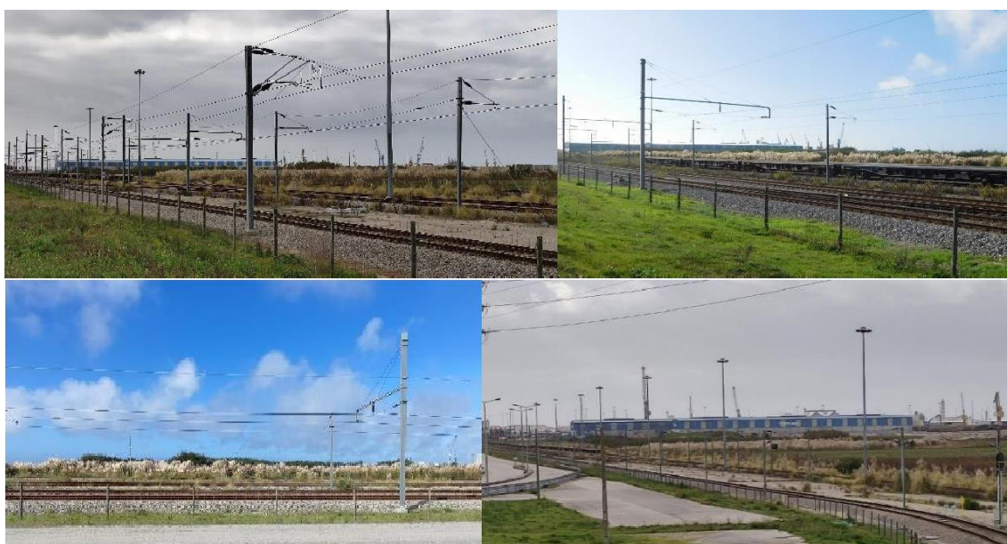
Figura 45: Linhas ferroviárias junto à área de intervenção do projeto (visita de campo, setembro de 2021).
